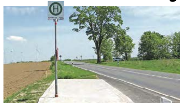
Am Halt „Bündigershof, Abzweig“ fährt die UVG-Linie 435 (Prenzlau ZOB-Wollin-Schmölln-Schwaneberg). Foto: SPREE-PR/Arbeit
